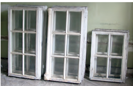
Zum Abbeizen vorbereitete Fensterrahmen
